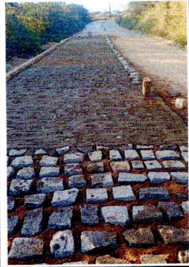
Lad. Val de Zé Preto. Pavimentação.
