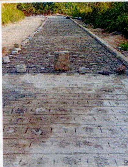
Lad. Val de Zé Preto. Pavimentação.
