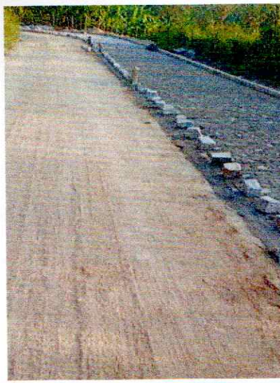
Lad. Val de Zé Preto. Pavimentação.
