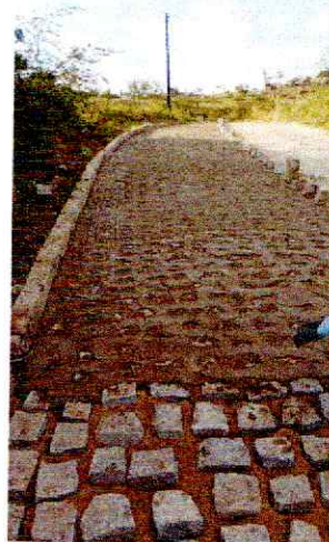
Lad. Val de Ze Preto. Pavimentação
