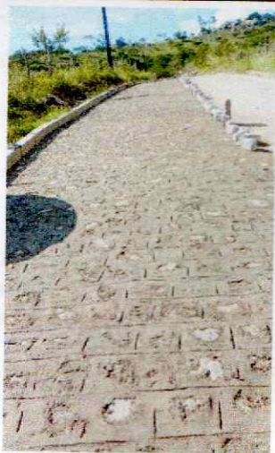
Lad. Val de Ze Preto.Pavimentação.
