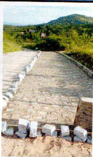
Lad. Val de Ze Preto. Pavimentação
